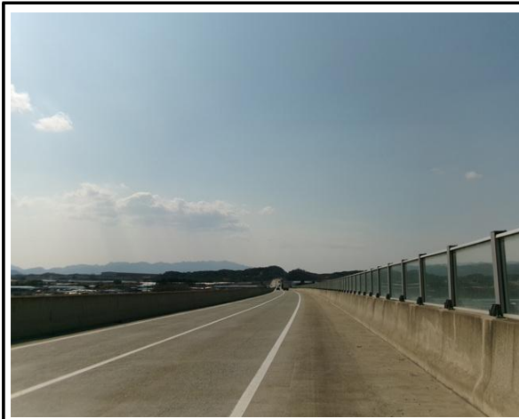
위 치 교면포장 현 황 전경
