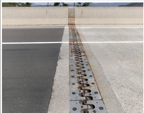
위 치 신축이음 현 황 전경
