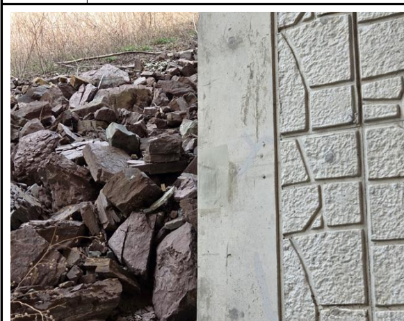
위 치 교대 상주방향 A2 현 황 교대 파손 보수
