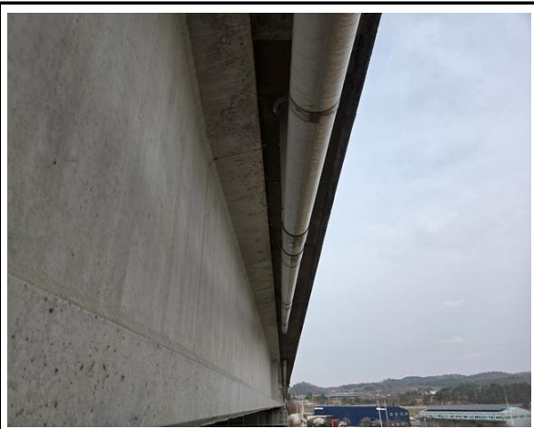
위 치 배수시설 현 황 배수관 전경
