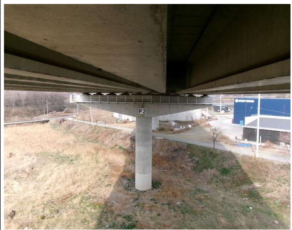
위 치 교각 현 황 전경
