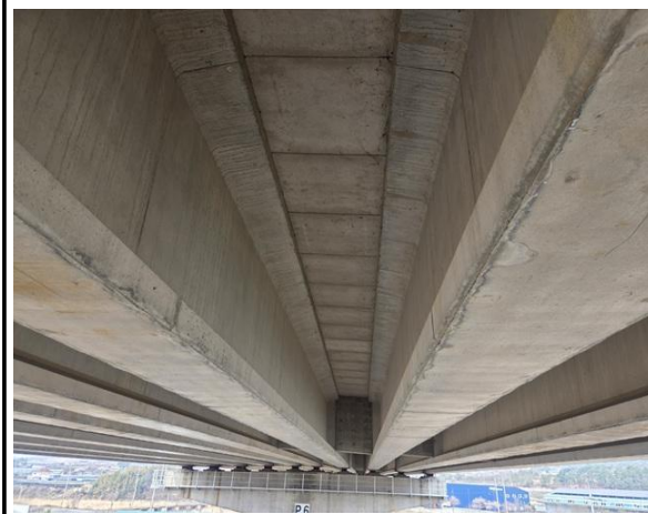
위 치 주형 (바닥판하면) 현 황 전경
